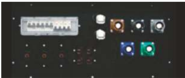
PANOU DE DISTRIBUȚIE CU CONECTOARE 250/400/650A
